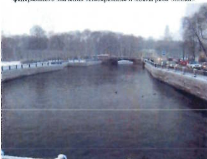
1. Набережные. Вид со стороны Инженерного Первого моста
