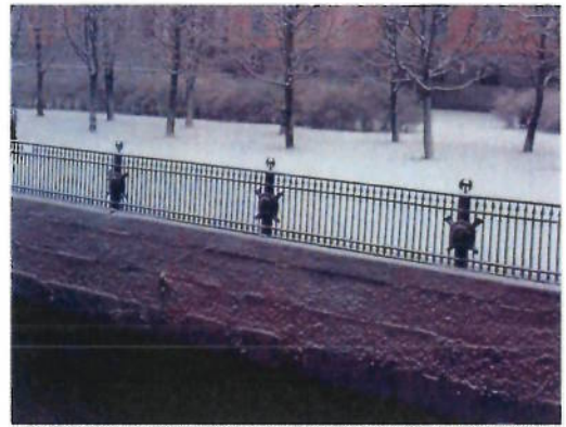
3. Ограждение набережной со стороны Михайловского (Инженерного) замка
