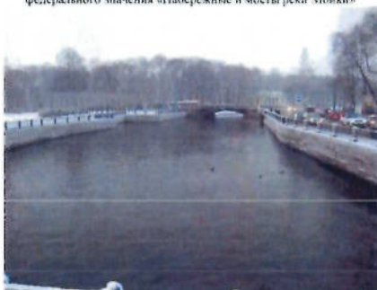
1. Набережные. Вид со стороны Инженерного Первого моста
