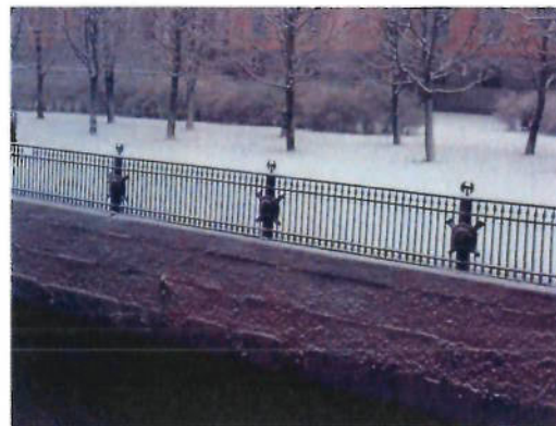
3. Ограждение набережной со стороны Михайловского (Инженерного) замка
